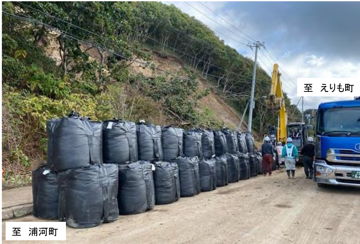
さまにちょうあざうとま (①) 国道336号 様似町字鶺鴒 応急復旧作業状況 (10月8日9:30時点)
