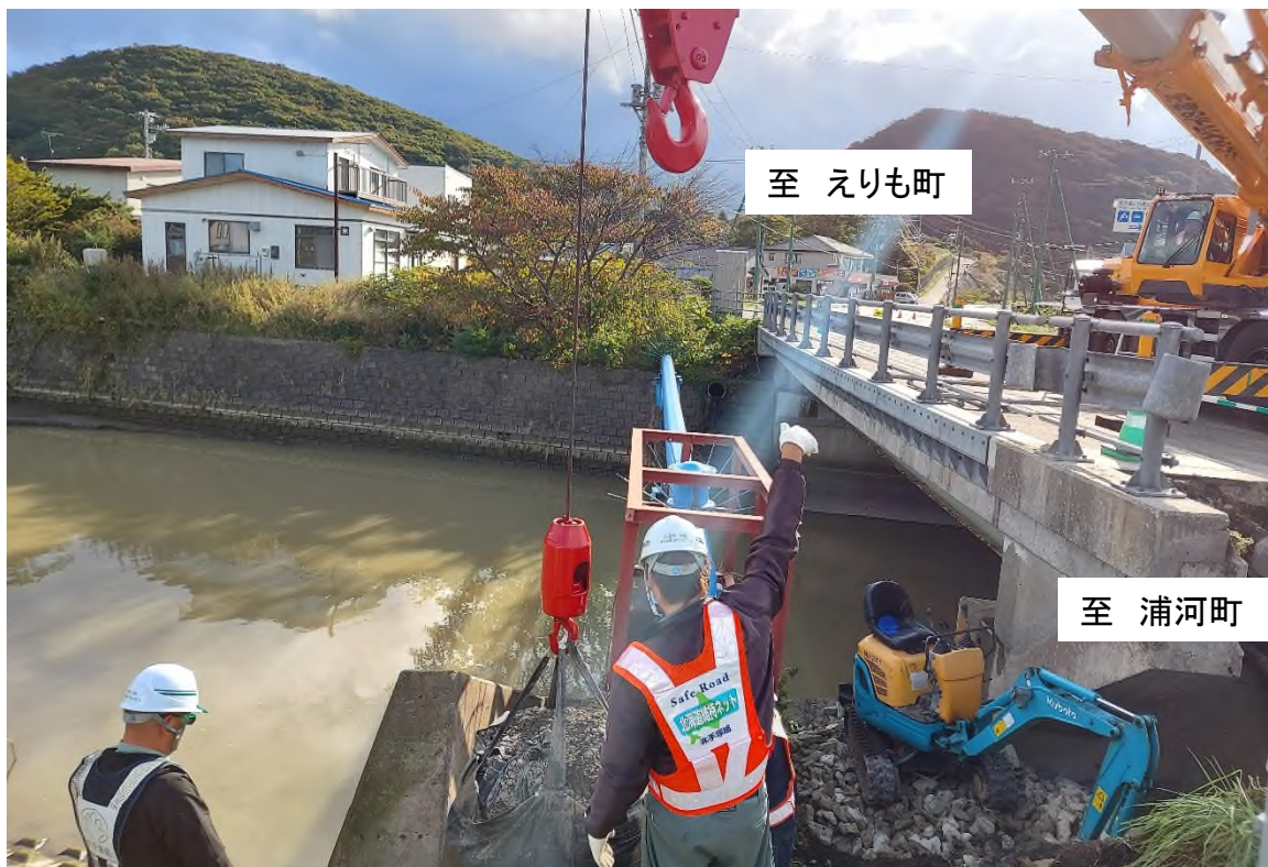
さまにちょうかんべつばし (③) 国道336号 様似町寒別橋 応急復旧作業状況 (10月8日10:00時点)
