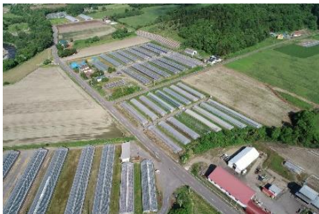
地熱利用しているハウス団地
