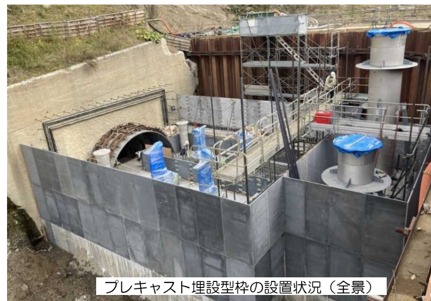
プレキャスト埋設型枠の設置状況 (クレーンでの荷降し据付による作業の簡素化)
