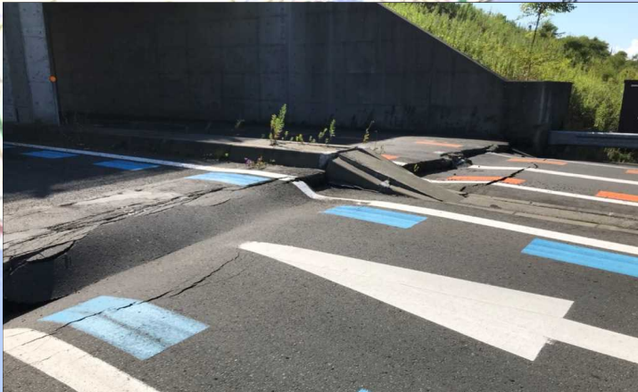
【写真①】鷓川ICランプのボックス部段差
