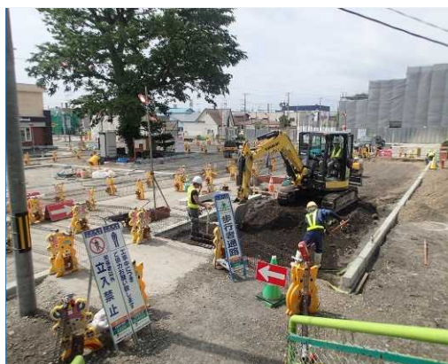
改築工事状況
