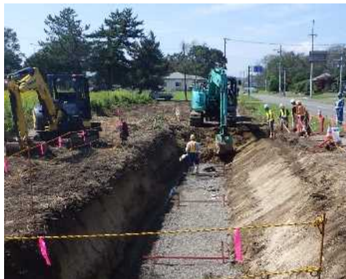
拡幅工事状況
