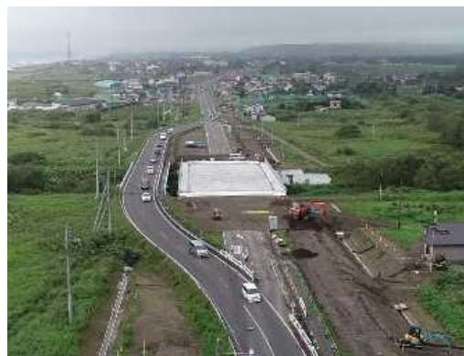
別々橋の架設完了状況
