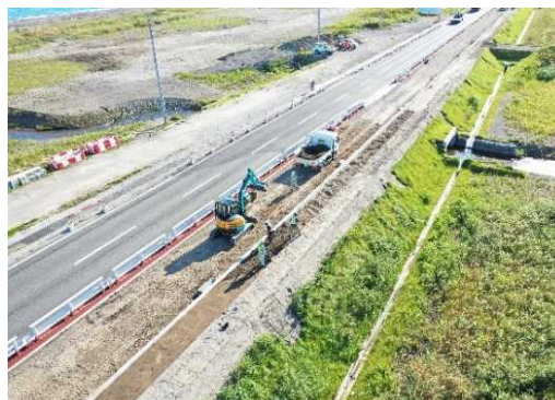
国道拡幅工事状況
