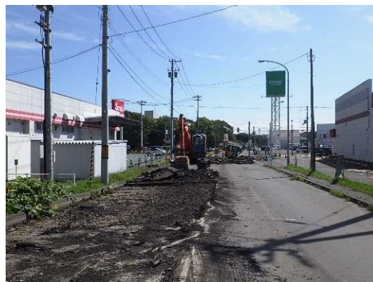
準備工事(舗装撤去)状況
