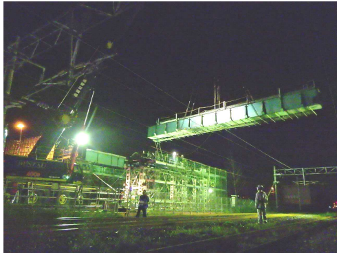
▲ (旧)緑跨線橋上部工撤去状況 【2018.09.12撮影】
