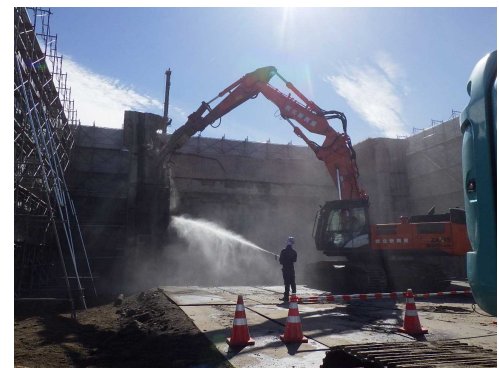
▲ (旧)緑跨線橋下部工撤去状況 【2018.10.12撮影】
