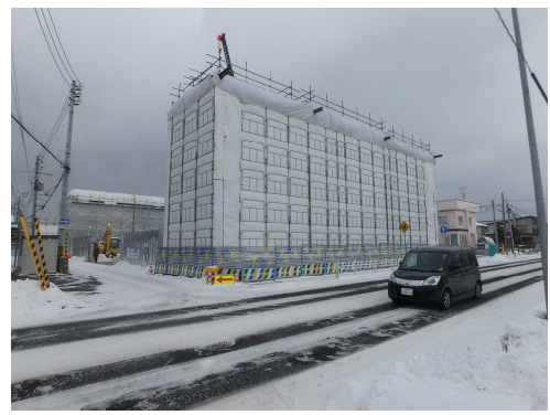
▲ (新)緑跨線橋下部工施工状況 (緑跨線橋南側より北側を望む) 【2019.02.08撮影】
