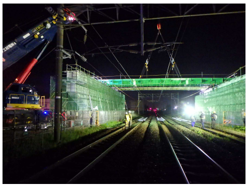
▲ (新)緑跨線橋上部工架設状況 【2019.05.24撮影】
