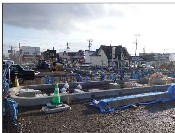
改築工事状況
