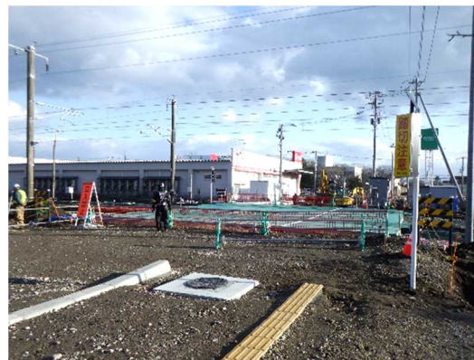
踏切拡幅工事状況
