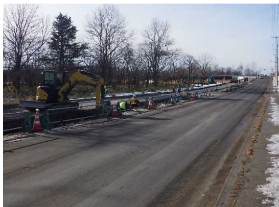
拡幅工事状況
