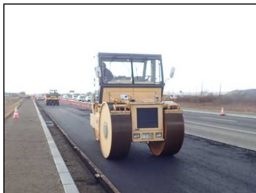
国道拡幅舗装工事状況
