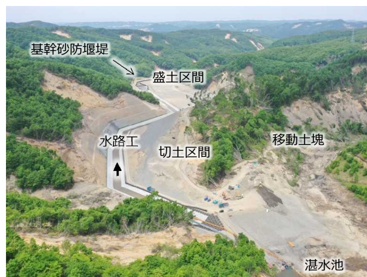
緊急対策工の完成状況(上流側から)
