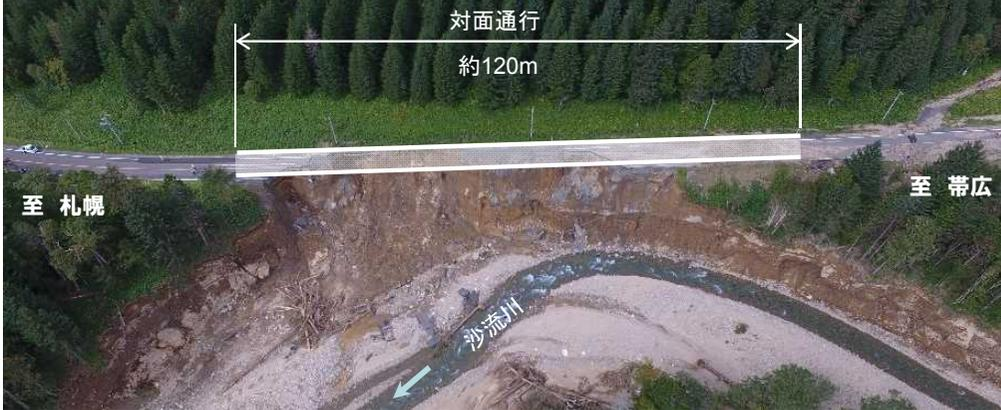
➤ 切土崩壊、盛土崩壊、土砂流出箇所および覆道の損傷箇所(三国の沢覆道)では、2車線を確保し、対面通行による開通を行う予定。
