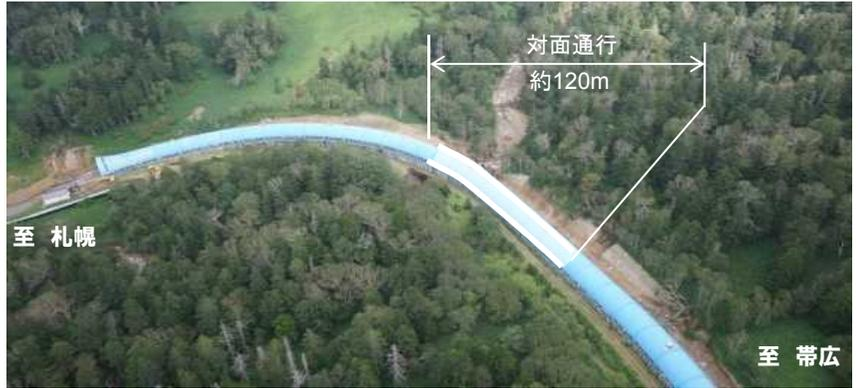
➤ 帯広側日勝峠7合目と8合目の道路本体が大きく欠損した箇所では、2車線を確保し、対面通行による開通を行う予定。
