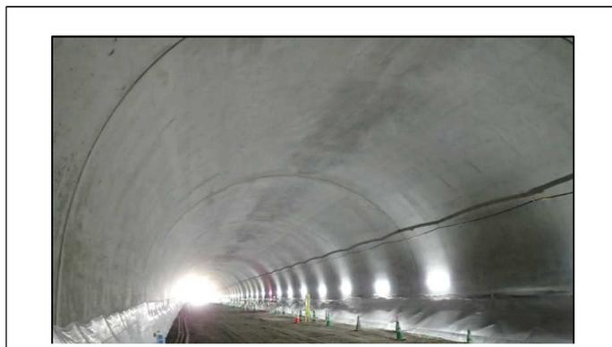
3月にトンネルの掘削が終了(貫通)したので、今年は覆工の状況を見ていただきます。(写真は覆工完成部)
