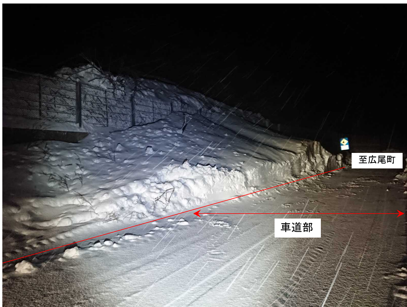
雪崩発生箇所状況
