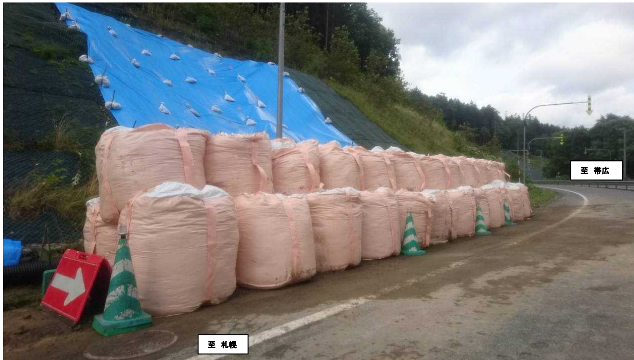
【復旧完了状況】
