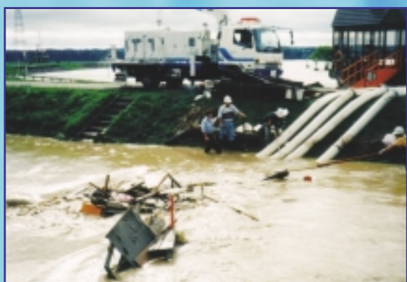
平成15年8月 台風10号 門別町沙流川栄町樋門付近での排水作業
