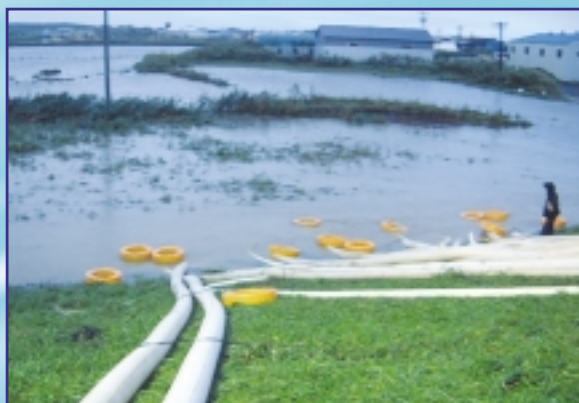
平成13年9月 台風15号 門別町沙流川富浜樋門付近での排水作業
