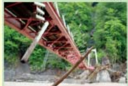
ダムサイト人道橋
