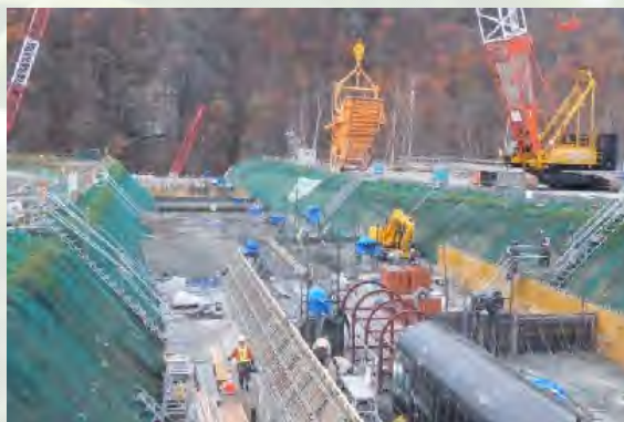
コンクリート打設
