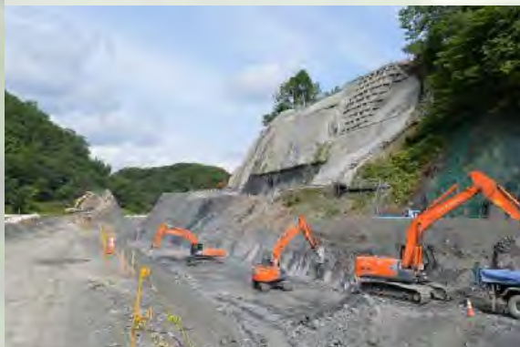
基礎掘削工事
