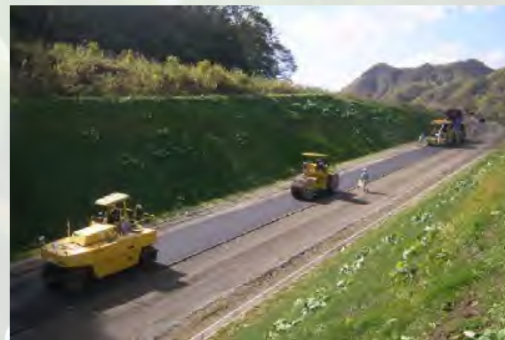
付替道道工事
