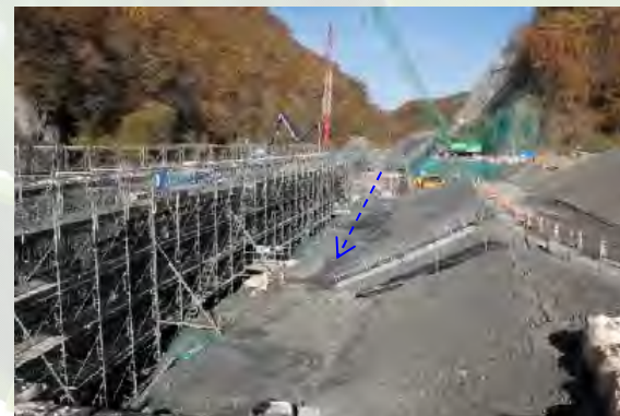
仮排水路工事
