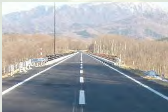
豊糠橋上部工
