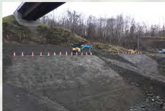
斜面对策工事
