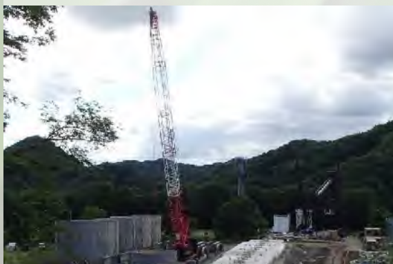
コンクリート製造設備 機械据付状況
