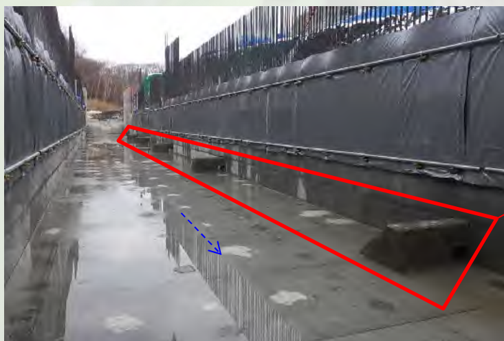
仮排水路（通水前） （下流から上流を望む）
