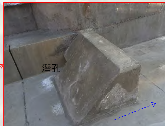
設置した水制
