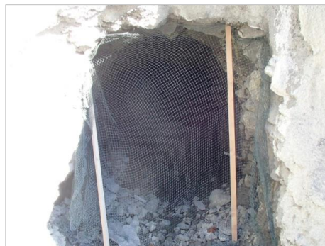
コウモリ類を封じ込めない ための侵入防止対策
