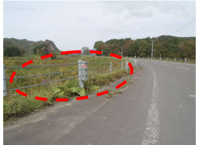
すずらん群生地周辺の眺望景観を阻害しないため、展望快適性に優れているガードケーブルを採用
