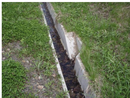
落下した小動物等の脱出対策 (スロープ付き道路側溝の設置)
