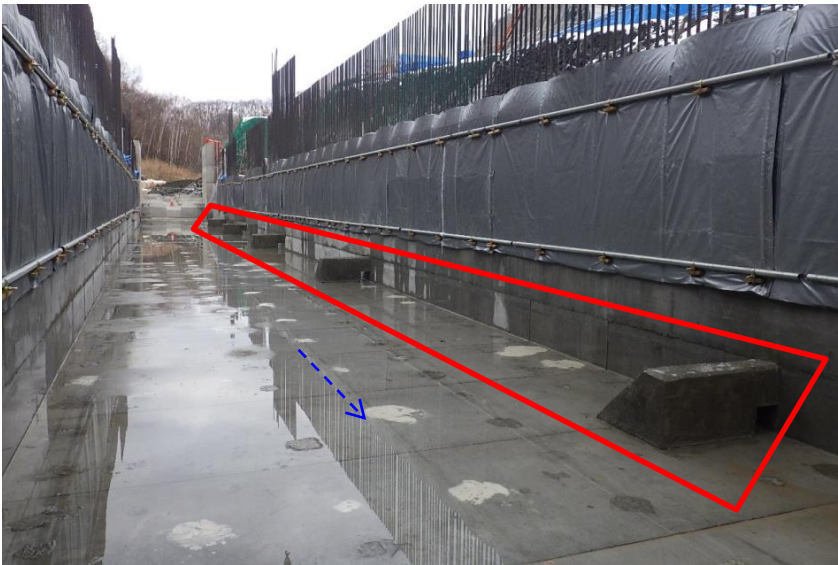
仮排水路（通水前）
