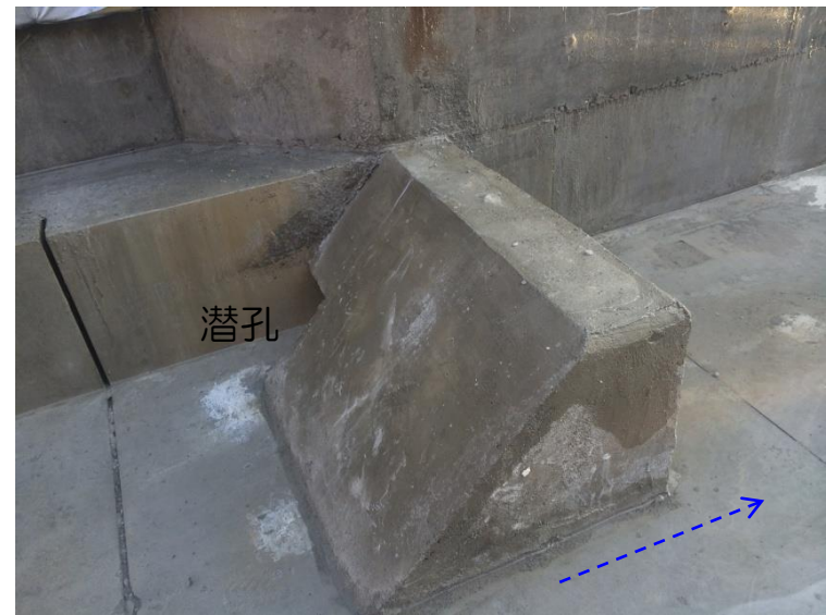
設置した水制
