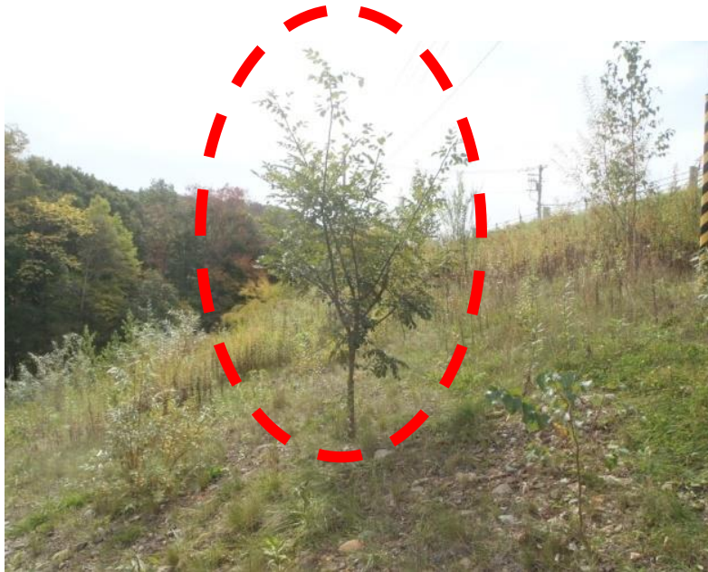
周辺景観との調和を図るため、工事後の盛土法面へ植栽した落葉広葉樹
