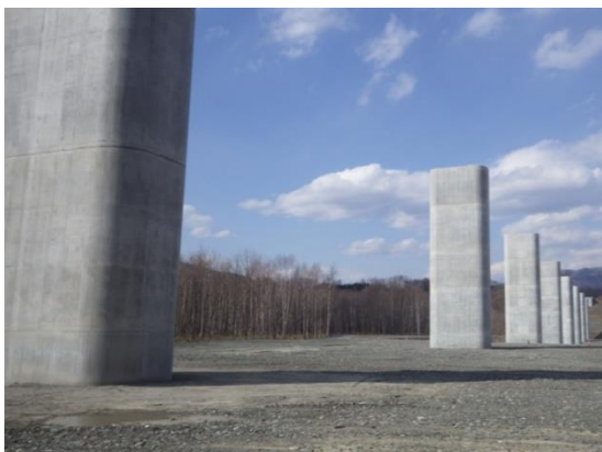
構造物の意匠 (コンクリート構造物のラウンディング処理)
