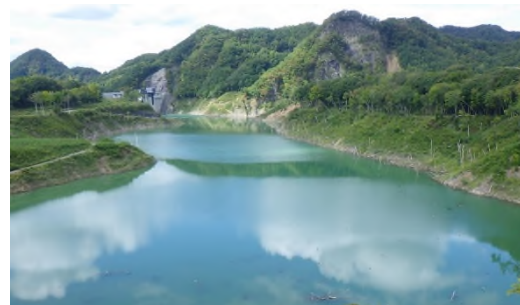
湛水時（令和6年9月24日）
