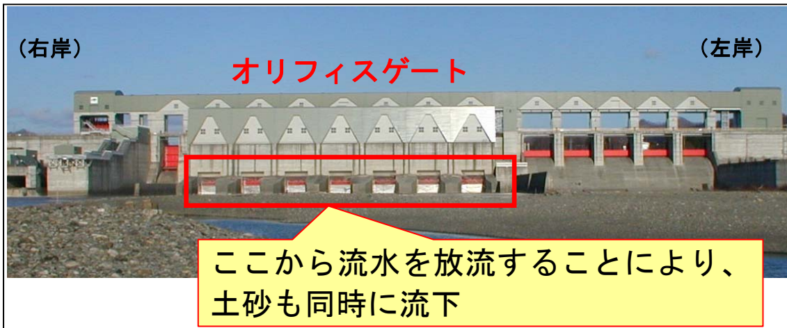
写真-1 二風谷ダムのゲートの位置
