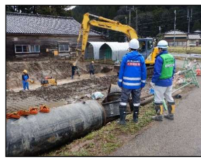
【復旧工事の状況】
