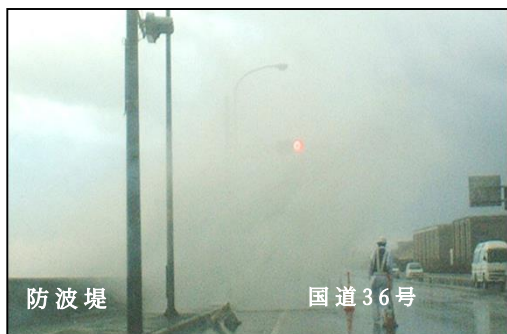
越波による通行規制状況
