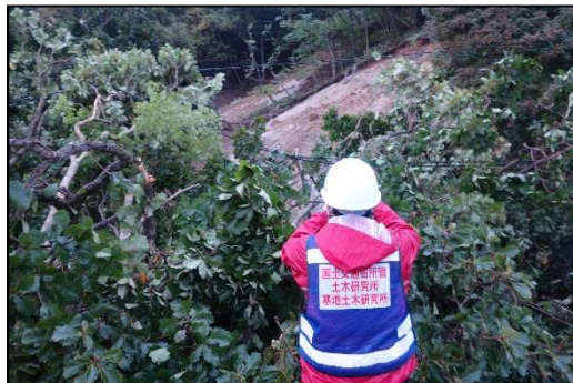
【国道付近地すべりの現地状況】
