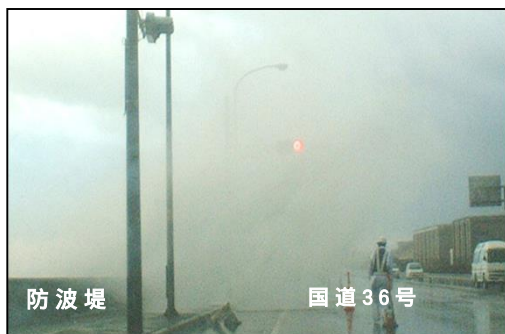
越波による通行規制状況
