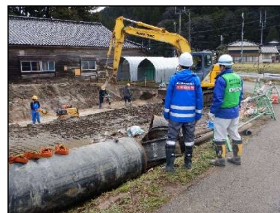
【復旧工事の状況】
