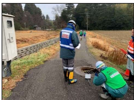
【農業集落排水施設の調査】
