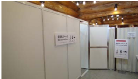
システムパネルで組んだ多目的スペース
