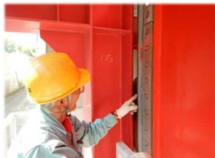
【ダム堤体・放流設備等の点検整備】
