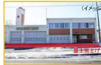
消防庁舎の嵩上げ(むかわ町)
