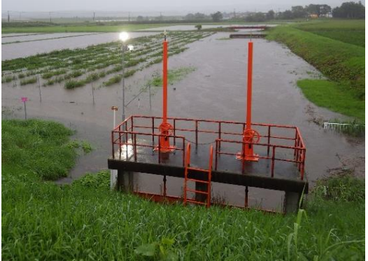
平成28年8月洪水 汐見樋門付近
