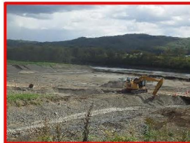
河道掘削(室蘭開発建設部)
