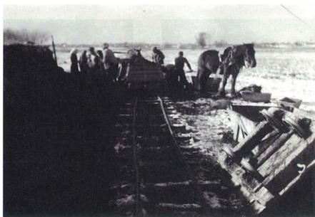
写真 1-6 馬トロによる築堤盛土(豊城築堤)
