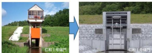
写真 2-3 浸水軽減対策(樋門の無動力化前) 写真 2-4 浸水軽減対策(樋門の無動力化後)
