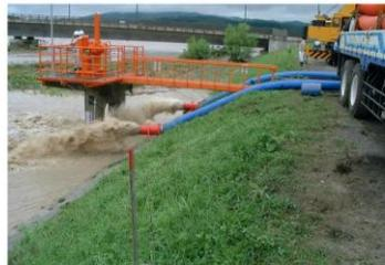
32 写真 1-25 ポンプ排水状況(穂別1号樋門、平成15年(2003年)8月洪水)
