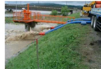
32 写真 1-25 ポンプ排水状況(穂別1号樋門、平成15年(2003年)8月洪水)
