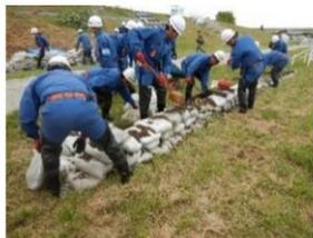
写真 2-33 防災機関による積み土のう工
