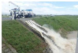
写真 2-2 ポンプ車による内水排除の状況
