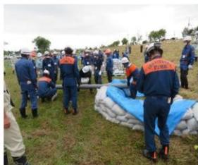
写真 2-35 月の輪工法
