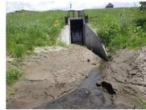
写真 2-31 堆積土砂掘削前
