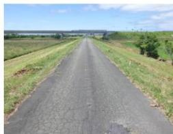
写真 2-23 堤防天端 補修実施前
