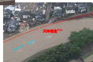
河岸侵食に伴う 家屋倒壊等
