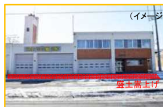
消防庁舎の嵩上げ(むかわ町)
