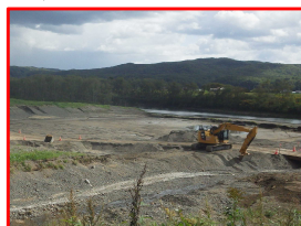
河道掘削(室蘭開発建設部)
