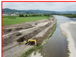
河道掘削（室蘭開発建設部）
