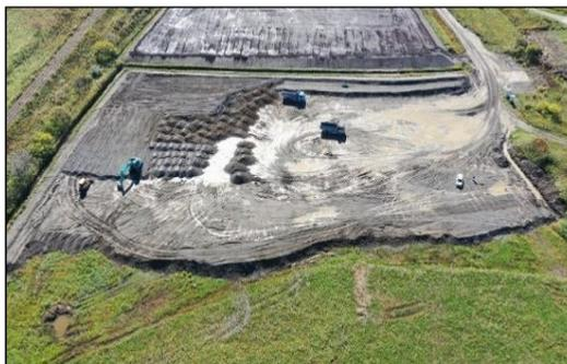
・河道掘削土の有効活用として、流域の農地へ運搬している。運搬先の農地では降雨の際の浸水被害の軽減のほか、浸水後の排水不良の軽減、隣接農地との標高を揃えることにより使いやすさを高めることなどの効果を期待。
