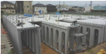
駐車場の地下に雨水貯留施設を設置した事例 (奈良県)
