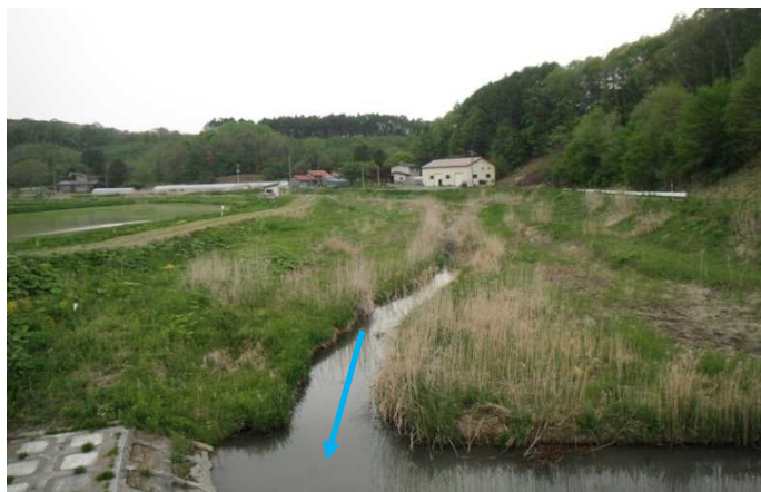
（ウクル川）河道掘削等の実施
