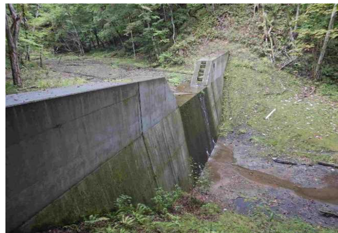
道有林内における治山ダムの整備
