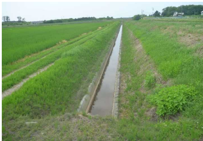
農業排水路の整備
