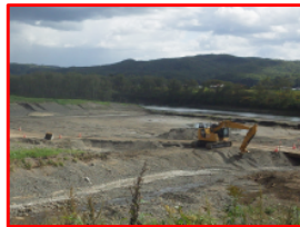
河道掘削(室蘭開発建設部)
