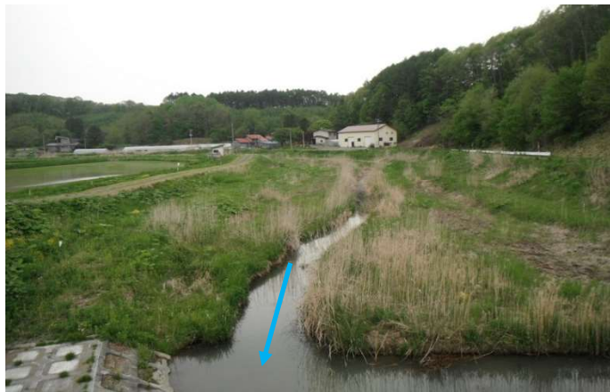
（ウクル川）河道掘削等の実施
