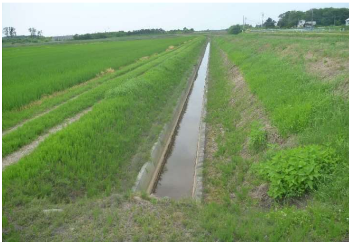
農業排水路の整備
