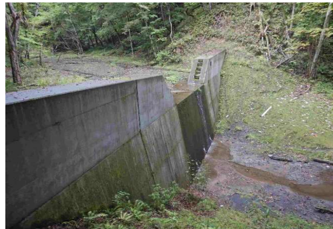
道有林内における治山ダムの整備
