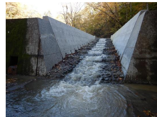
アベツ川治山工事(施工後)
