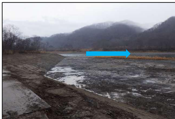
河道掘削 完成(沙流川)
