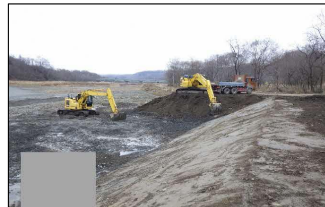
河道掘削 (沙流川)
