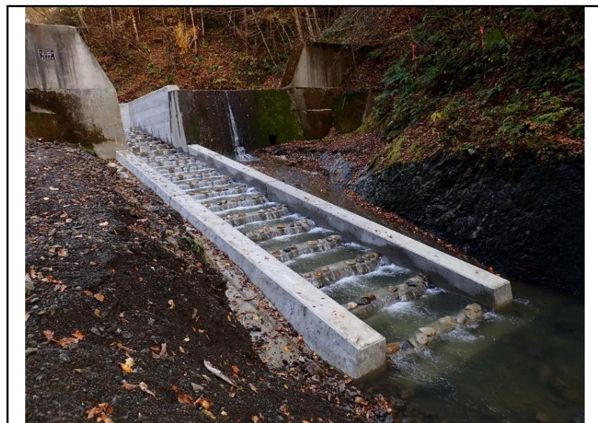
施工後(張出部)
