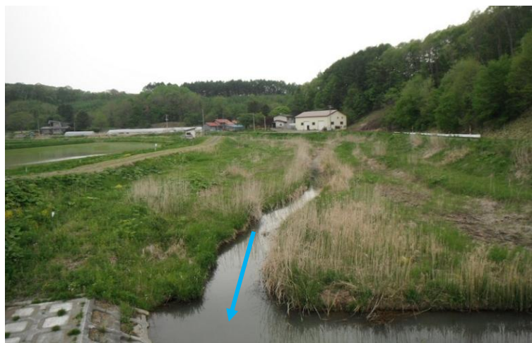
（ウクル川）河道掘削等の実施
