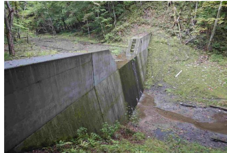
道有林内における治山ダムの整備
