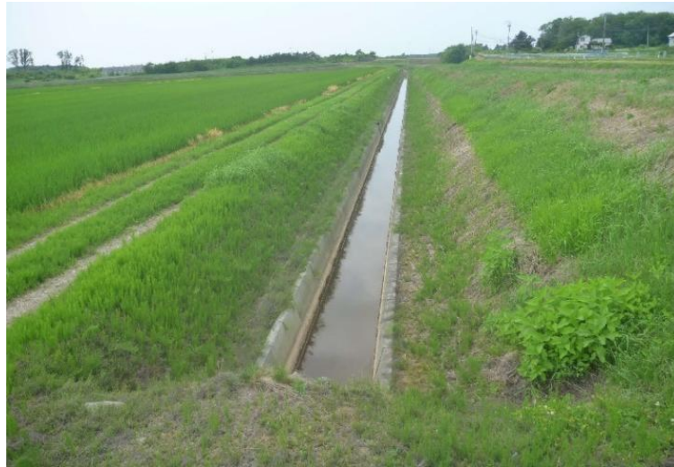
農業排水路の整備
