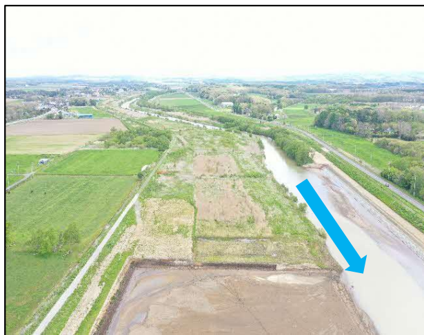
河道掘削 着工前 (厚真川)
