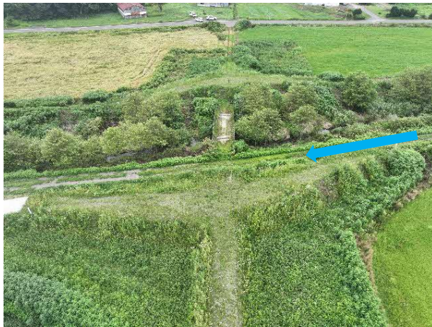
河道掘削 着工前（入鹿別川）橋梁工
