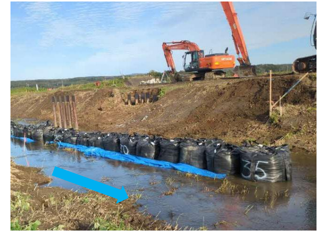
河道掘削 （入鹿別川）
