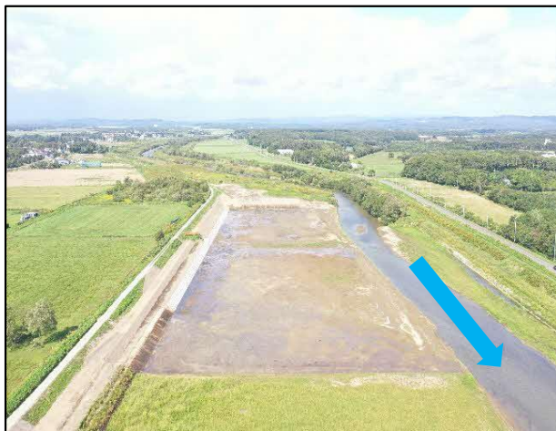
河道掘削 完成 (厚真川)
