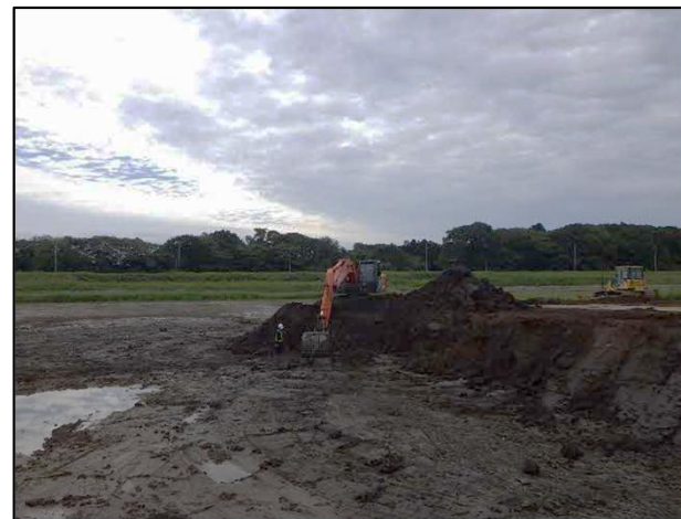
河道掘削 (厚真川)
