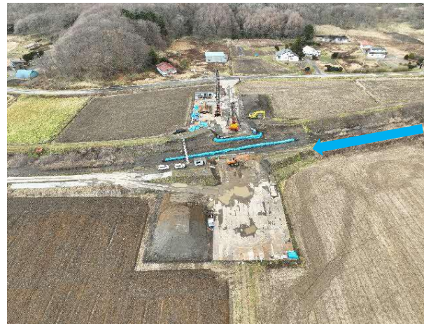
河道掘削 （入鹿別川）橋梁工
