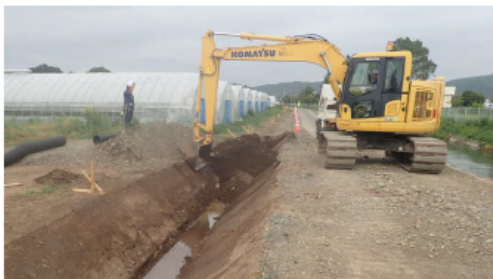
農業整備事業(排水路整備)
