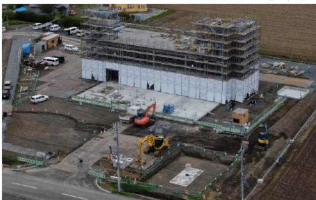
むかわ町 消防庁舎(鶴川支署)の嵩上げ
