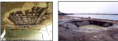
内部の鉄筋が露出した橋梁 陥没した港湾施設のエプロン部分
