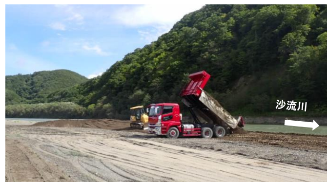
河道掘削の土砂還元
