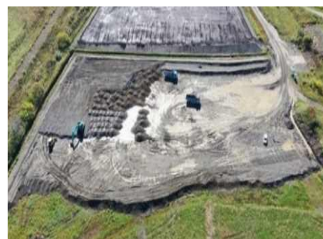
河道掘削土を活用した農地の嵩上げ
