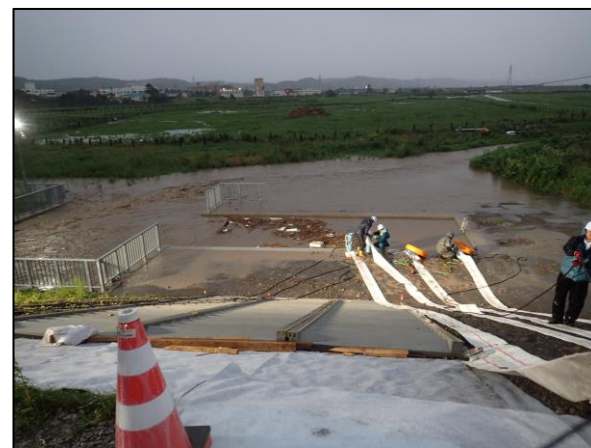
富川D樋門 ポンプ車排水状況 (平成28年(2016年)8月洪水)
