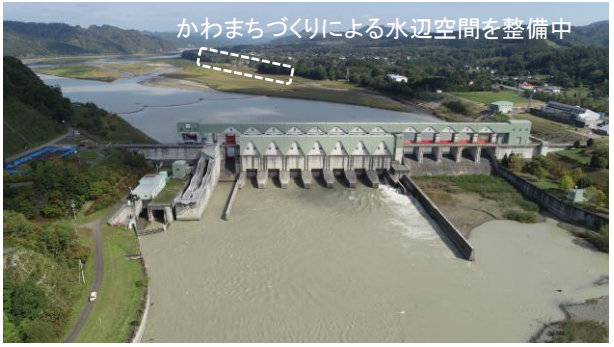
試行前の状況（R4.9.29撮影 EL=約40.0m）
