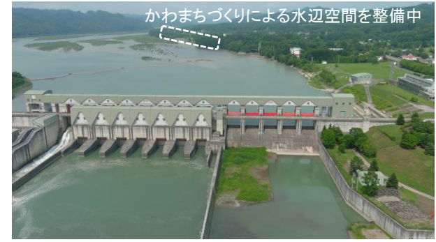
試行後の状況（R7.7.3撮影 EL=約41.5m）
