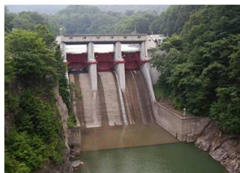
既存ダムの事前放流(岩知志ダム)
