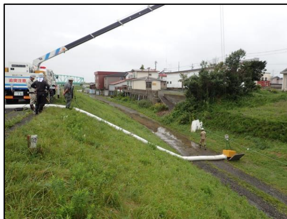
栄町樋門 ポンプ車排水状況 (平成28年(2016年)8月洪水)
