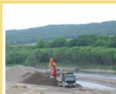
河道掘削した土砂を、
