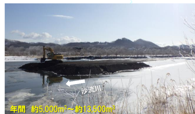
二風谷ダム下流の土砂還元
