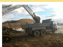
ダンプトラックへ積み込み、
