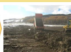
土砂が流出した農地へ運搬し、
