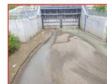
写真 2-31 堆積土砂掘削前
