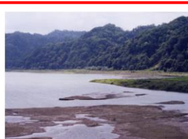
写真1-2-9 にぶたに湖右岸 （貯砂ダム下流）
