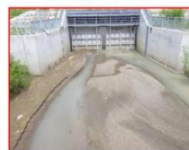
写真 2-31 堆積土砂掘削前
