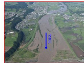
写真 1-13 日高町富川地区出水状況 （平成28年（2016年）8月洪水）
