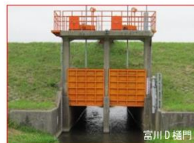
写真 2-3 浸水軽減対策（樋門の無動力化前）
