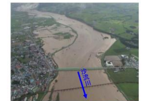
出典：北海道開発局 写真 1-10 富川地区浸水状況（下流から望む） （平成15年（2003年）8月洪水）
