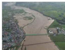
写真 1-2-6 平成 15 年 8 月洪水 富川地区浸水状況（下流から望む）
