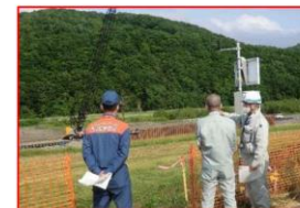
写真 2-22 合同巡視状況
