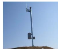
監視用カメラ
