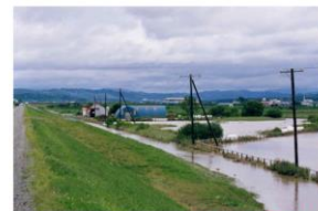
出典：北海道開発局 写真 1-8 河口左岸内水氾濫状況 （平成4年（1992年）8月洪水）
