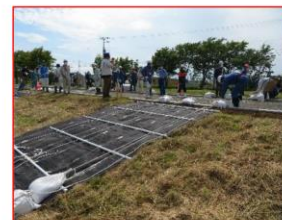
写真 2-34 シート張工法
