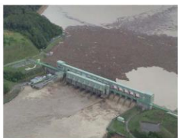
写真 1-2-5 平成 15 年 8 月洪水 二風谷ダム洪水調節状況（下流から）
