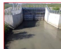
写真 2-32 堆積土砂掘削後
