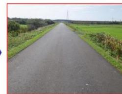
写真 2-26 堤防天端 補修後
