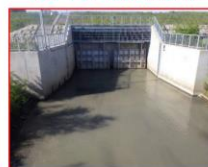
写真 2-32 堆積土砂掘削後
