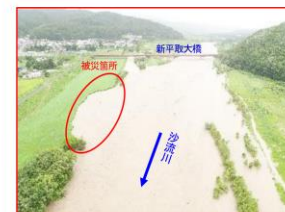
写真 1-15 平取町河岸侵食状況 （令和4年（2022年）8月）
