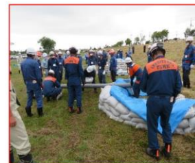
写真 2-35 月の輪工法
