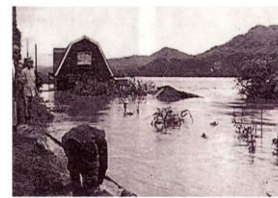
出典：鶴川沙流川治水史 写真 1-6 平取町沙流川右岸浸水倒壊家屋 （昭和37年（1962年）8月洪水）
