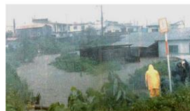
出典：鶴川沙流川治水史 写真 1-7 沙流川右岸 C 樋門内水氾濫・門別町富川 （昭和56年（1981年）8月洪水）
