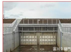
写真 2-4 浸水軽減対策（樋門の無動力化後）
