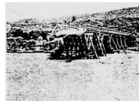
出典：鶴川沙流川治水史 写真 1-5 流失した振内橋 （昭和36年（1961年）7月洪水）
