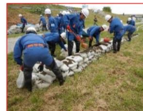
写真 2-33 防災機関による積み土のう工
