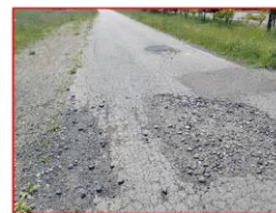
写真 2-25 堤防天端 補修前
