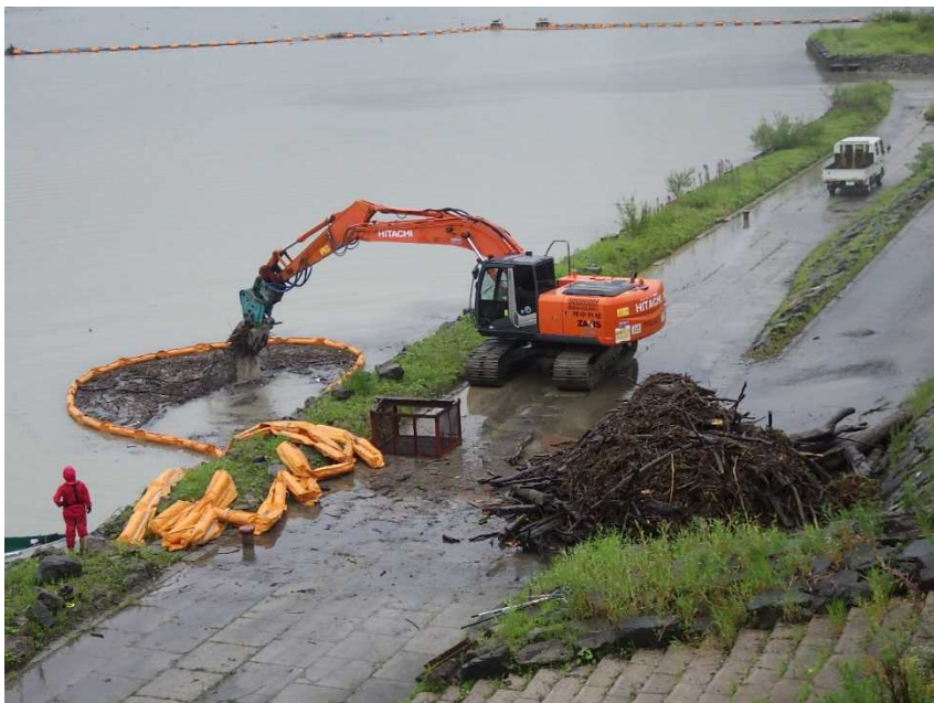
【ダム湖内の流木回収】
