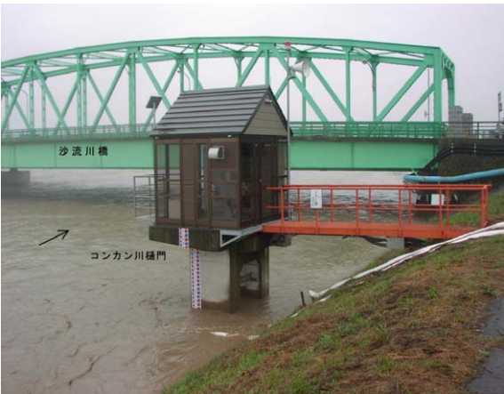
コンカン川樋門付近出水状況
