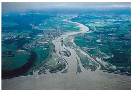
沙流川河口 出水状況
