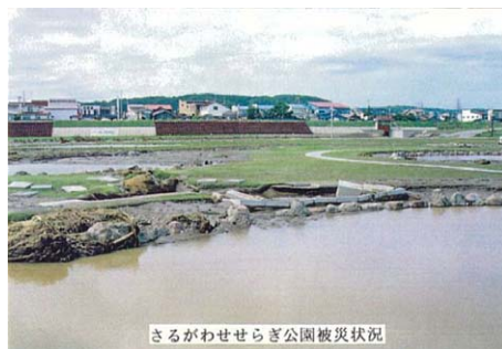
さるがわせせらぎ公園被災状況
