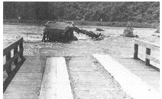
平取大橋の流失・平取町 (昭和30年7月)
