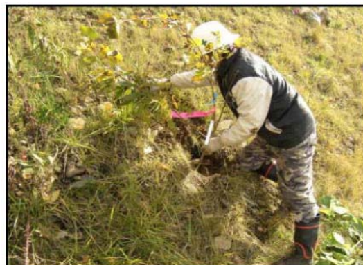
写真 3.2-1 道路法面の植栽状況
