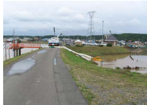
排水ポンプ車による排水状況
