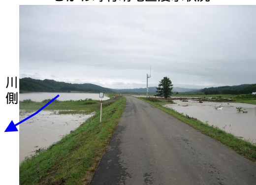
むかわ町有明地区浸水状況
