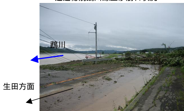
道道穂別鶴川線土砂崩れ状況
