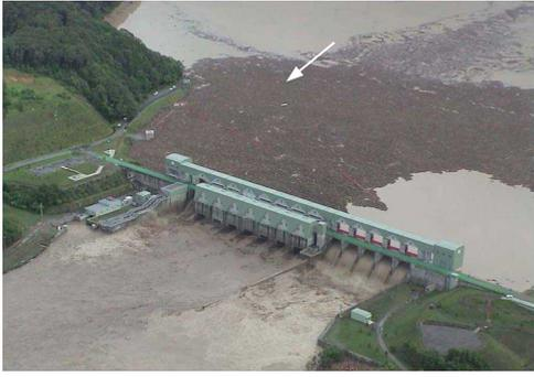
平成 15 年 8 月洪水 二風谷ダム洪水調節状況
