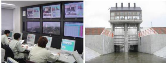
写真 2-1-2 樋門樋管改築 遠隔操作化イメージ写真
