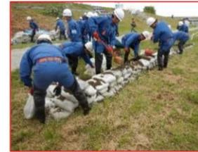
写真 2-33 防災機関による積み土のウ工
