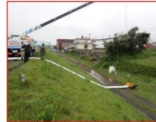
写真 2-1 栄町樋門 ポンプ車排水状況
