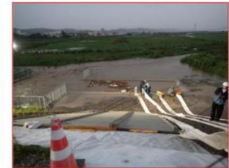
写真 2-2 富川D樋門 ポンプ車排水状況
