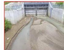
写真 2-31 堆積土砂掘削前
