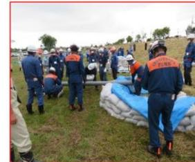
写真 2-35 月の輪工法
