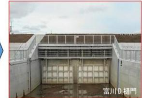
写真 2-4 浸水軽減対策(樋門の無動力化後)
