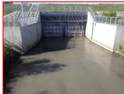
写真 2-32 堆積土砂掘削後
