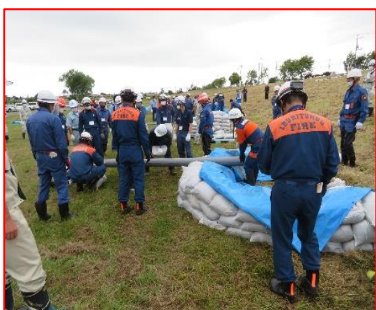
写真 2-35 月の輪工法
