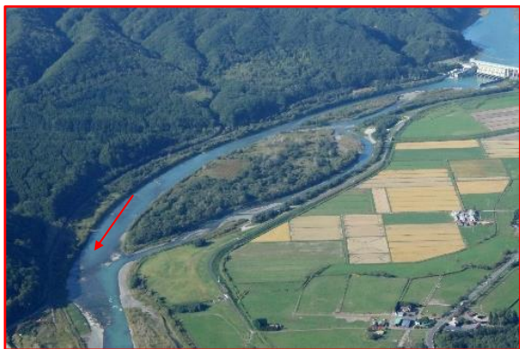
写真 2-7 沙流川上流部 (KP20.0付近)
