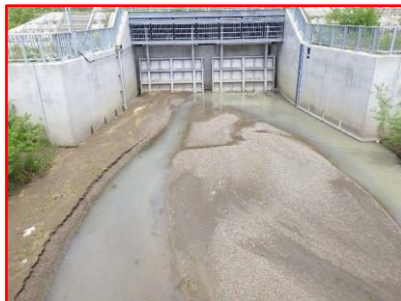
写真 2-31 堆積土砂掘削前
