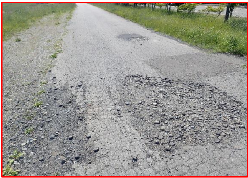
写真 2-25 堤防天端 補修前
