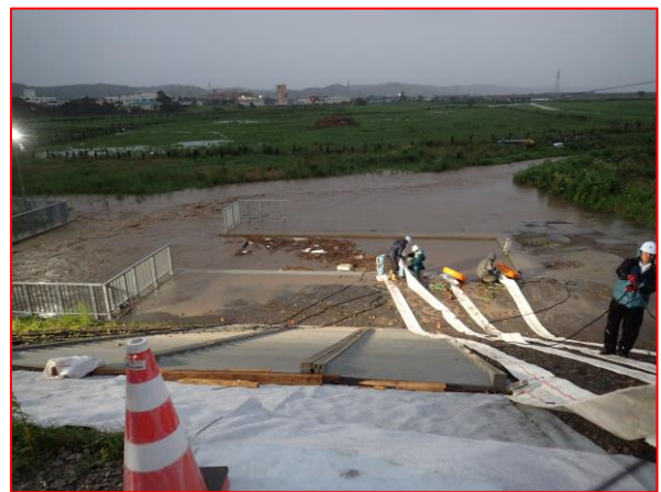
写真 2-2 富川D樋門 ポンプ車排水状況 (平成28年(2016年)8月洪水)
