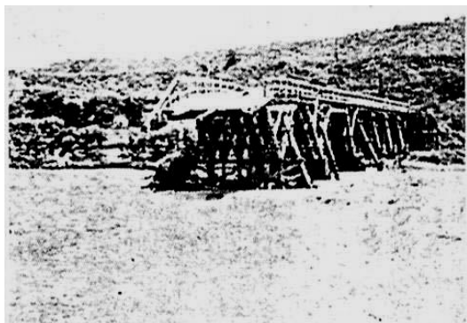
出典：鶴川沙流川治水史 写真 1-5 流失した振内橋 (昭和36年 (1961年) 7月洪水)
