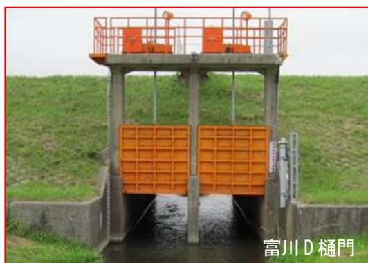
写真 2-3 浸水軽減対策（樋門の無動力化前）
