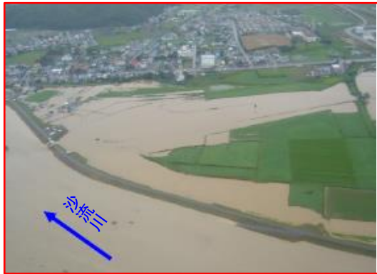
出典：北海道開発局 写真 1-11 日高町富川地区浸水状況 (平成18年(2006年)8月洪水)
