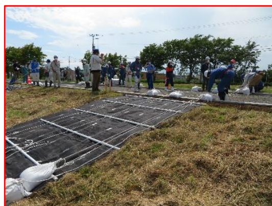
写真 2-34 シート張工法
