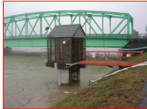
出典：北海道開発局 写真 1-12 コンカン川樋門出水状況 (平成18年(2006年)8月洪水)
