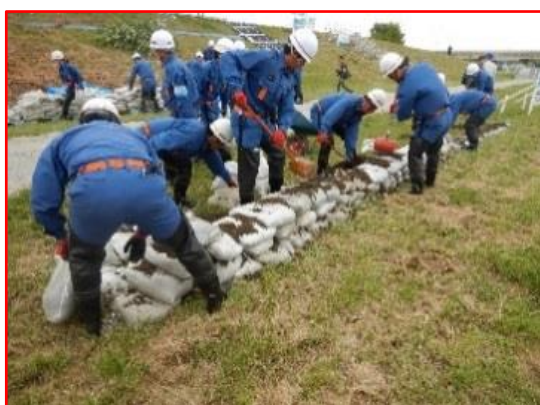
写真 2-33 防災機関による積み土のう工
