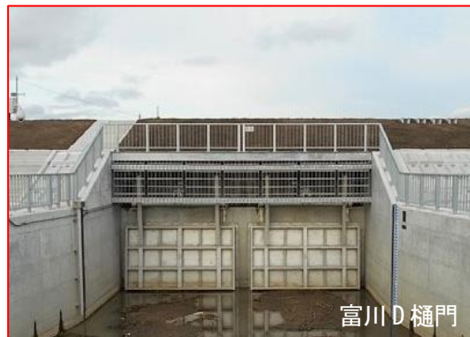
写真 2-4 浸水軽減対策（樋門の無動力化後）
