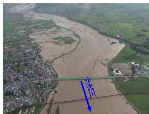
出典：北海道開発局 写真 1-10 富川地区浸水状況 (下流から望む) (平成15年 (2003年) 8月洪水)
