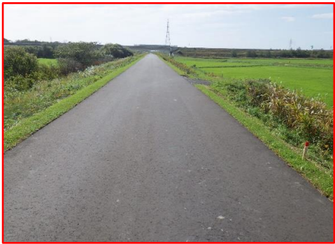
写真 2-26 堤防天端 補修後
