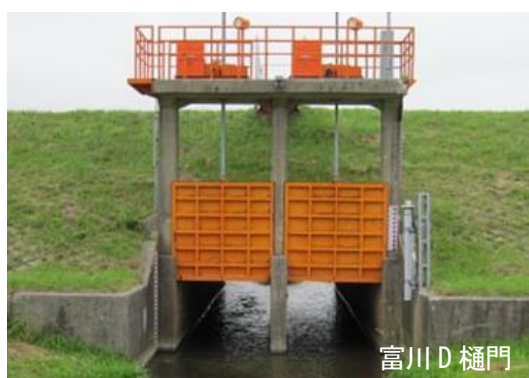
写真 2-3 浸水軽減対策（樋門の無動力化前）
