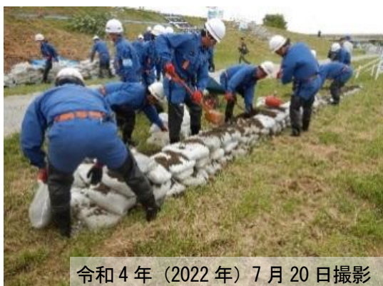
写真 2-33 防災機関による積み土のう工
