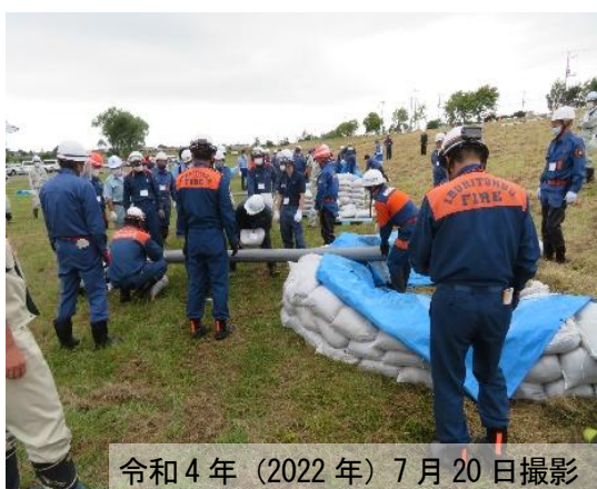
写真 2-35 月の輪工法
