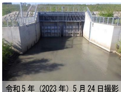
写真 2-32 堆積土砂掘削後
