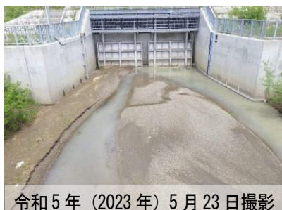
写真 2-31 堆積土砂掘削前
