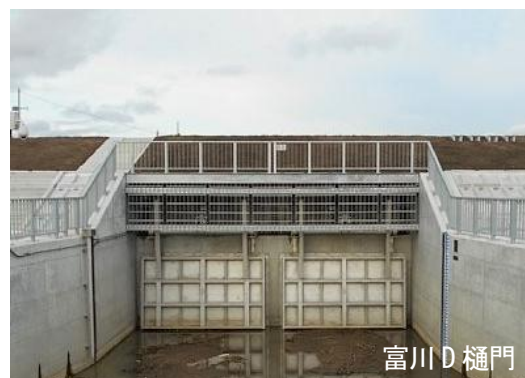
写真 2-4 浸水軽減対策（樋門の無動力化後）
