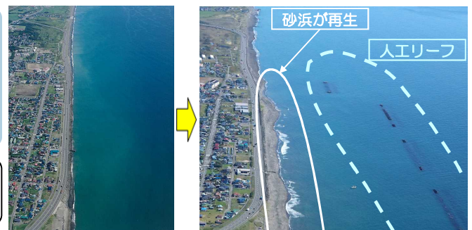
白老工区人工リーフによる砂浜の再生(左:着手前、右:整備後)
