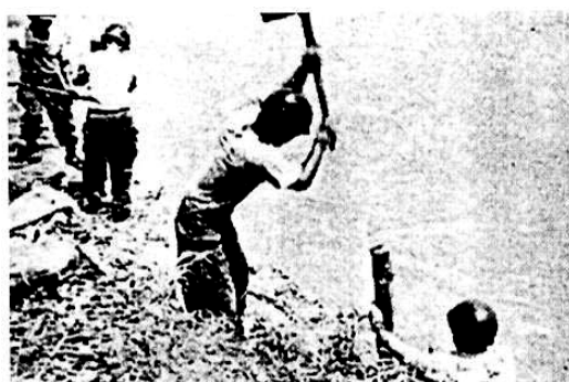
写真 1-2-2 昭和 36 年 7 月 26 日洪水 懸命に護岸作業を行う自衛隊員
