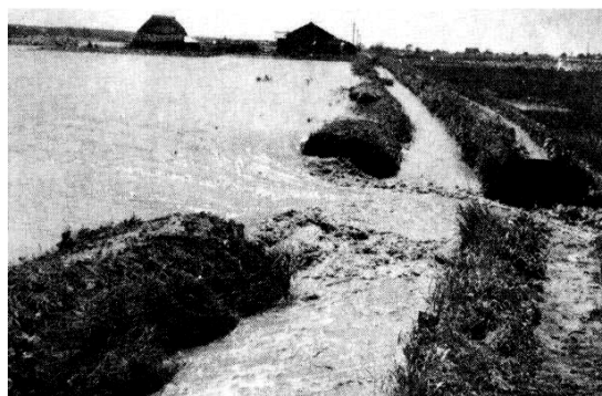
写真 1-2-4 昭和 37 年 8 月 4 日洪水 沙流川氾濫による灌漑溝決壊
