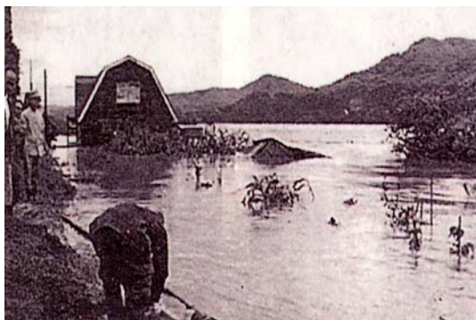
写真 1-2-3 昭和 37 年 8 月 4 日洪水 平取町沙流川右岸浸水倒壊家屋
