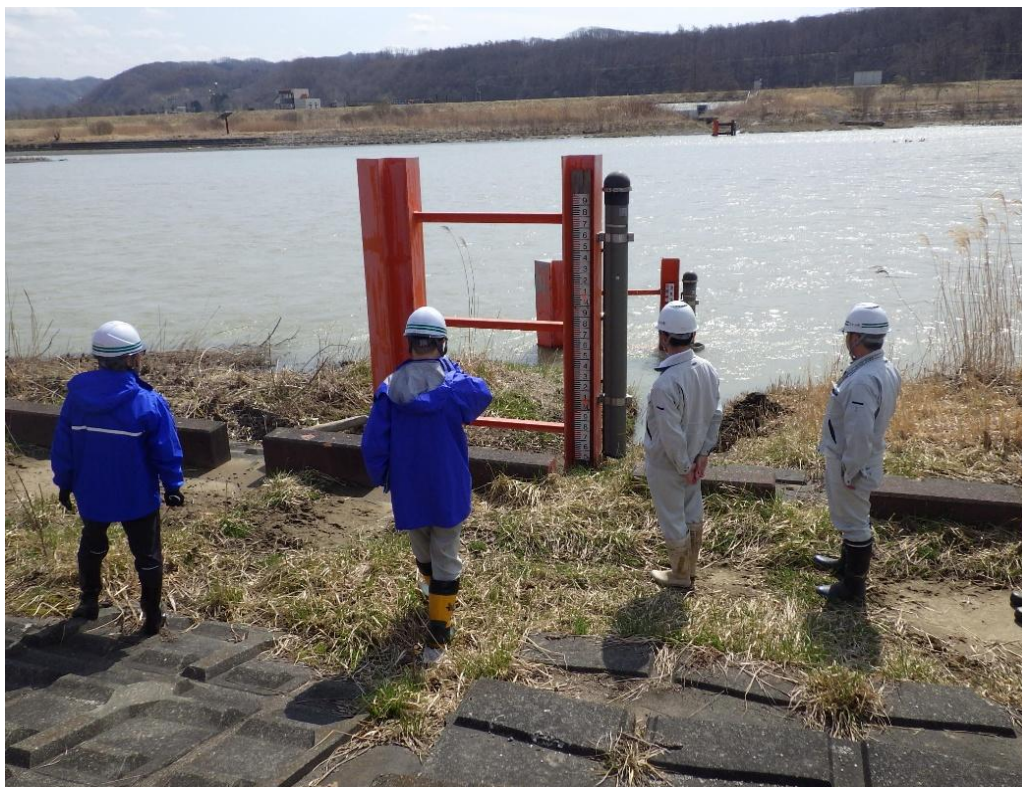
写真② 河川管理施設点検 @鶴川(穂別川沿公園)
