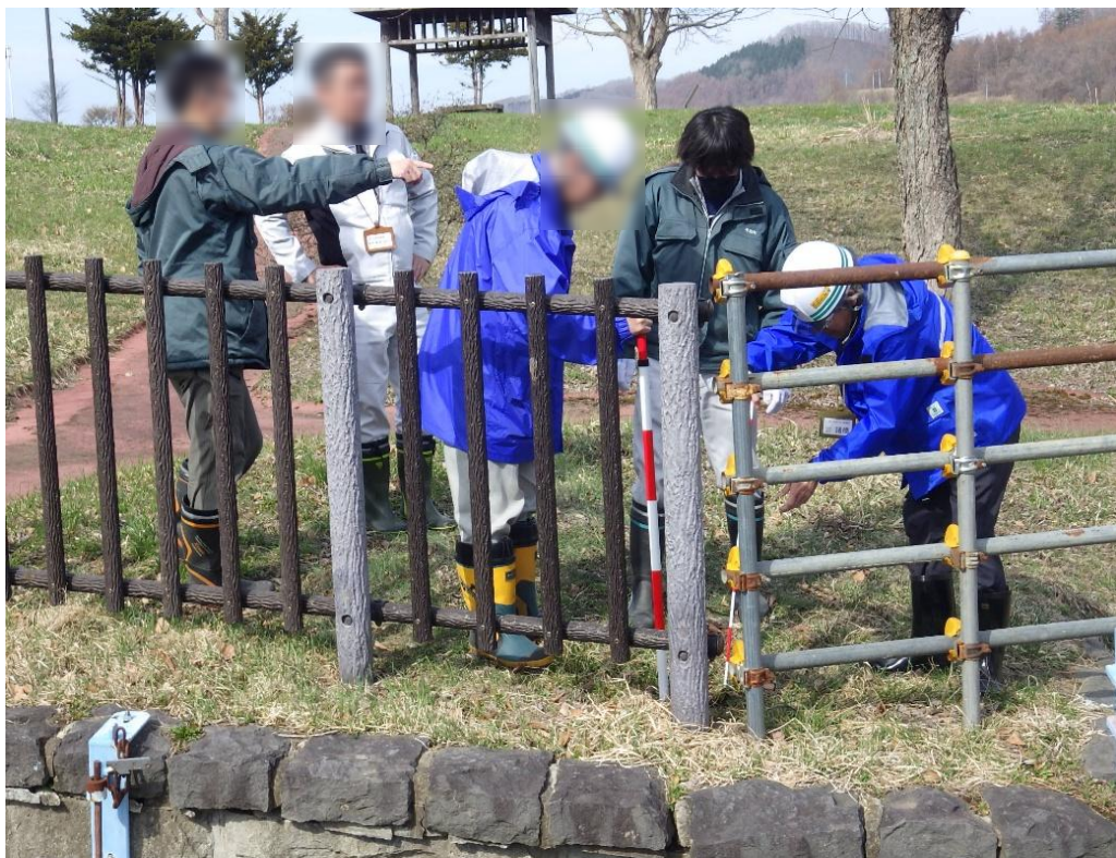
写真④ 河川管理施設点検 @沙流川(平取親水公園)
